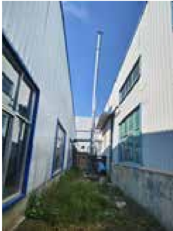
图3-1 活性炭吸附+P2排气筒
