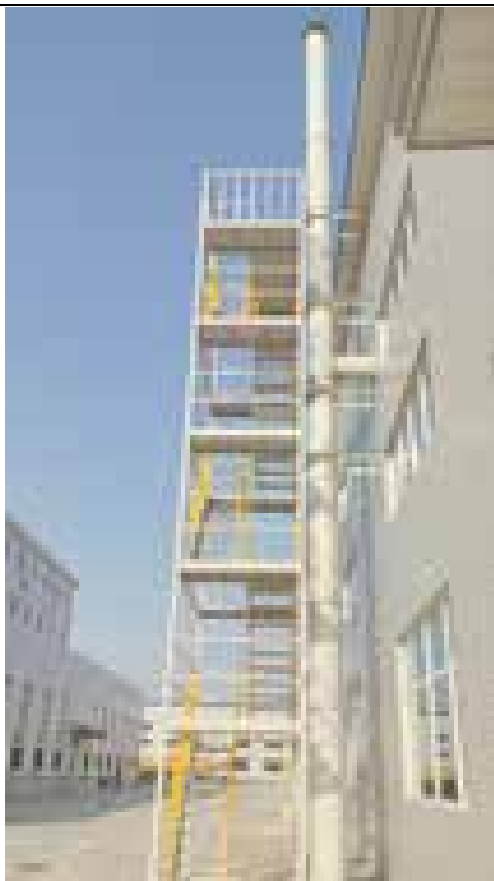
图 4.2-1 规范化废气排放口及采样平台
