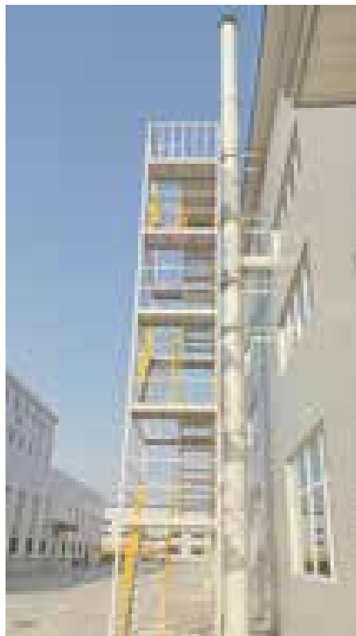
图 4.1-1 “旋风除尘器+脉冲袋式除尘器”+DA013 排气筒图
